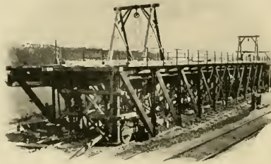
Abb. 170 Auswechslung des Viaducts bei Stranov.
